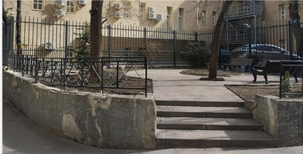
Полянка Б. ул. 1/3
