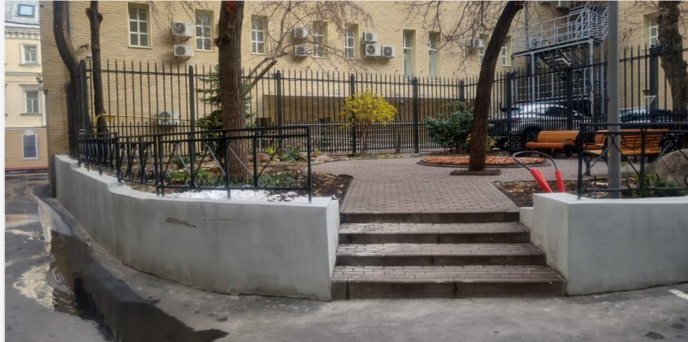
Полянка Б. ул. 1/3
